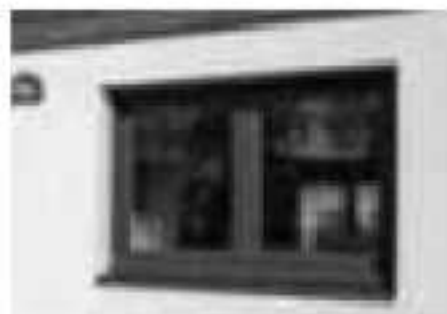
coffre invisible de l'extérieur
